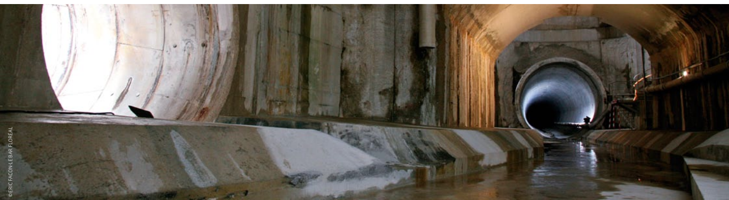
↓ Jonction du tunnel Ivry-Massena. Le SIAAP prépare, en matière d'assainissement le Grand Paris de l'après 2030.
