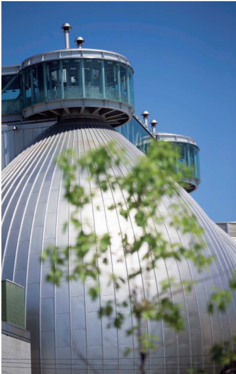
À Brooklyn, Newtown Creek est la plus grande des 14 usines de traitement des eaux usées de la ville de New York.
